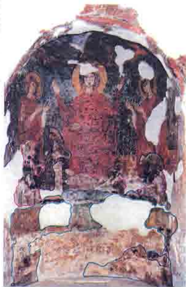
Abside, palinsesto. Indicazione degli strati sovrapposti (dopo il restauro)
